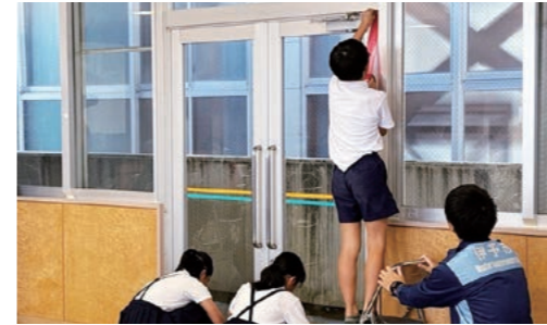
養生による隙間の解消
