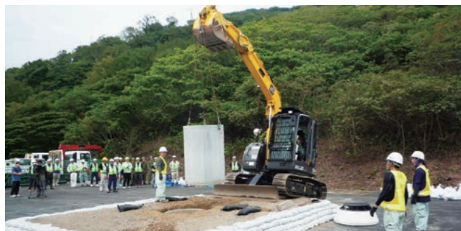
隆起したマンホールの除去
